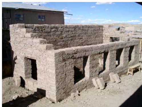
Construcción de un fitotoldo en Yauri
